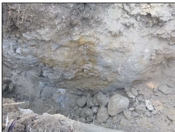
Sol : molasse sablo-argileuse +/- grésifiée Puits P2 : tenue des parois précaire
